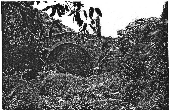
Fig. 4 Puente del Camino de la Sierra de Sedella
