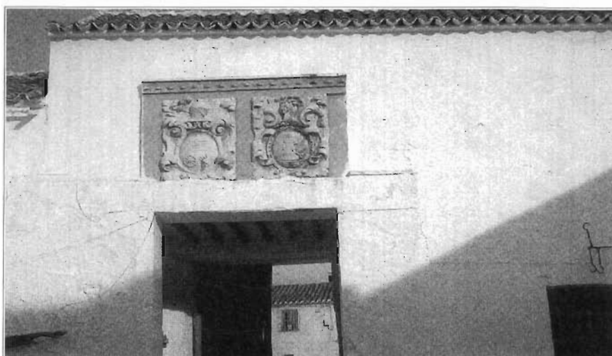
Escudos nobiliarios en el interior del patio «Cortijo de la Marquesa»
